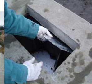
底板プレート 設置状況
