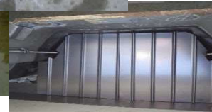
底板プレート設置後
