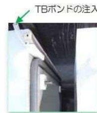
上面から下方を見る
