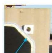
充填後 TBボンドの充填部(内目地)
