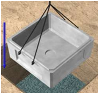
②吊金具をつけて本体下部B1部 材(底付)を4点吊りで据付します。
