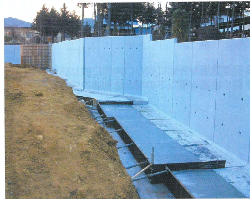
施工状況（底版部現場打ち）
