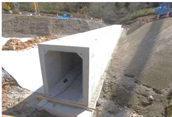
ボックスカルバート 施工状況
