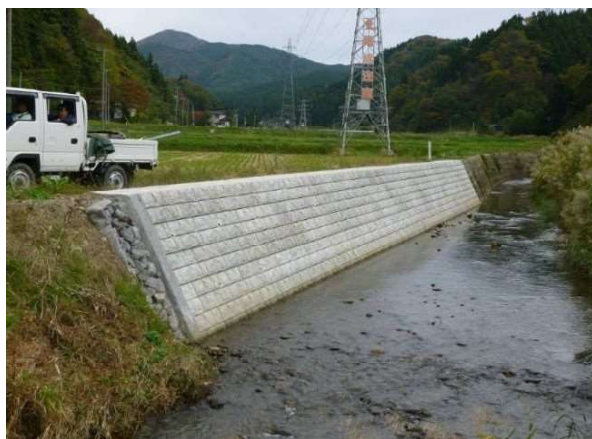
美山AK-Ⅱ 施工写真
