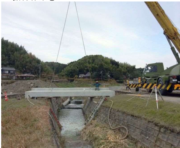
3. 据付作業②
