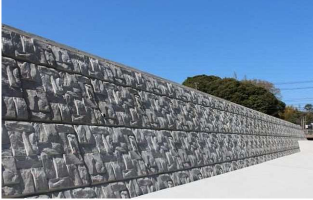
KPブロック施工写真
