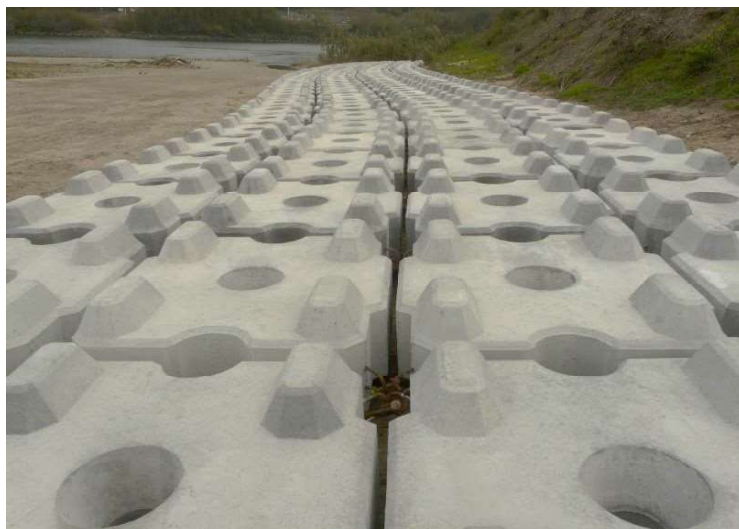
ブロック施工写真
