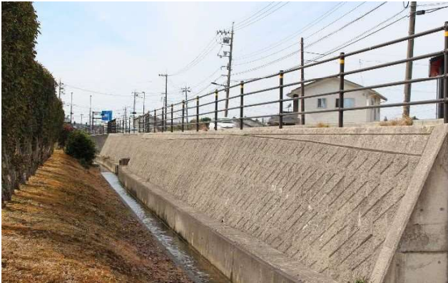
安定スプリット施工写真
