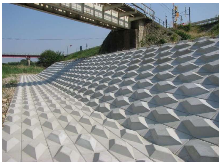
ヤカット施工写真
