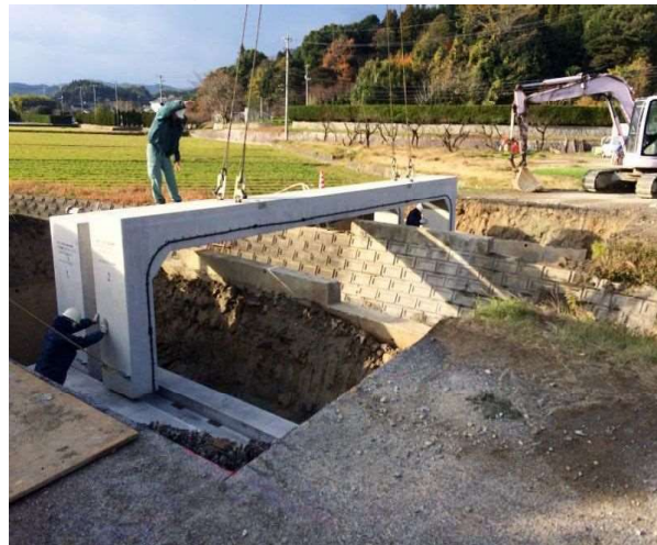
2. 据付作業①
