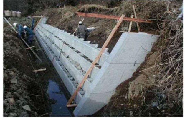
ブロック積みに合わせて設置する
