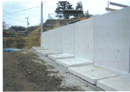
敷き段差施工
