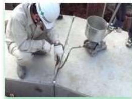
頂版から注入
